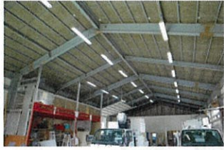
折板屋根 倉庫
