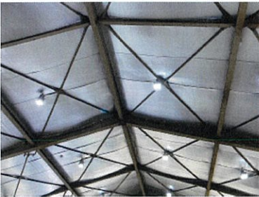
折板屋根 工場
